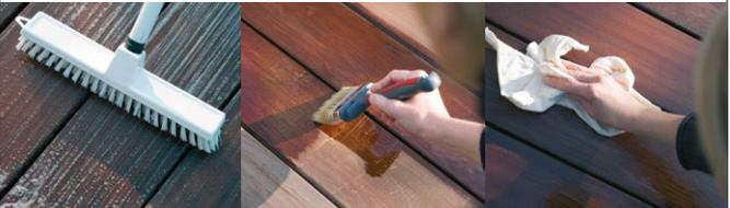
Um Rissbildungen und Ausblutungen an den Schnitt- und Strinkanten zu verhindern empfehlen wir die Verwendung unserer **Hirnholz- und Kantenversiegelung**.
