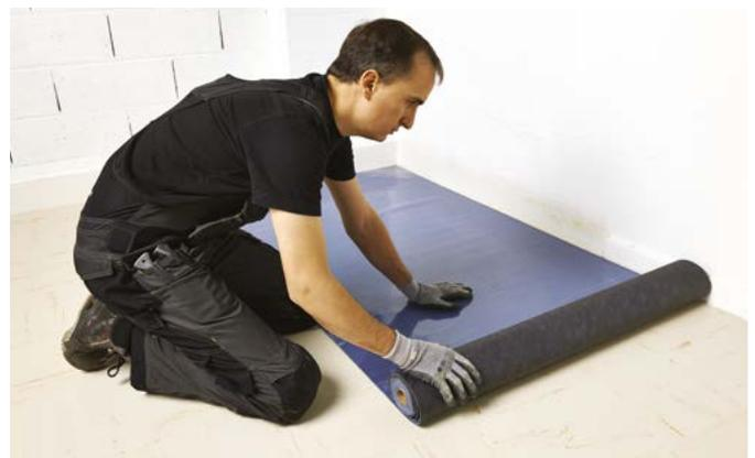
Arbeiten Sie in dem Verlegebereich stets von links nach rechts. Dabei zeigen die Federseiten der Planke / Fliese zur Wand. Verlegen Sie die Elemente mit der Stirnseite in Richtung Haupt-Lichtquelle des Raumes. Sie können die Eigenstabilität des verlegten Bodens deutlich verbessern, indem Sie in langen, schmalen Räumen in Längsrichtung verlegen.
