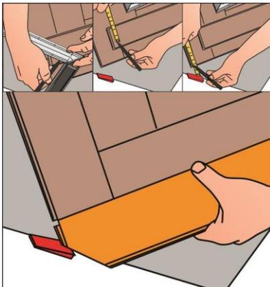
Für die letzte Reihe benötigen Sie die zugeschnittenen Stücke der ersten vier Reihen (im Bild orange markiert). Schneiden Sie gegebenenfalls die Dielen in der entsprechenden Länge zu, damit diese angelegt werden können.
