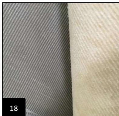
Im Anschluss, aber nicht später als 30 Minuten nach dem manuellen Anreiben, erfolgt das gleichmäßige und langsame Anwalzen (17) des Belages mittels einer Gliederwalze (Gewicht mind. 50kg). Kontrollieren Sie die ausreichende Benetzung (18) des Belages mit Klebstoff.
