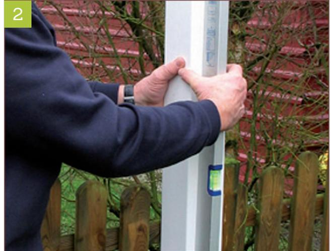
2 | Nachdem Sie den Pfosten mit der Wasserwaage ausgerichtet haben, kontrollieren Sie den Abstand von Oberkante Gelände zur Unterkante Befestigung. Dieses Maß sollte je nach Vorgartenzaunhöhe 78 cm oder 105 cm betragen (seitliche Zaunhöhe + 15 cm Variationsspiel).
