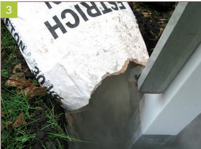
3 | Betonieren Sie jetzt die Pfosten in das Erdloch ein. Verfahren Sie mit den nachfolgenden Pfosten ebenso.
