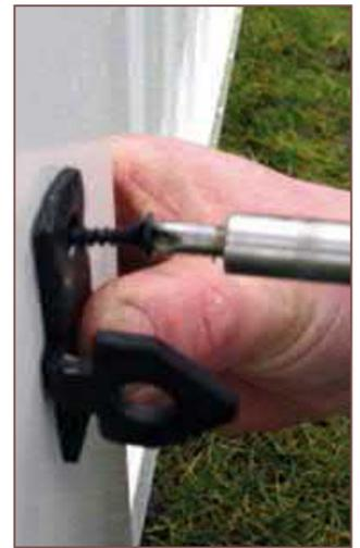
6 | Für die 1-flügelige Pforte befestigen Sie die Aufhängungen und den Klinkhaken auf der Rückseite der Pfosten (DIN Richtung beachten!). Bohren Sie die Löcher mit einem 3,5 mm -HSS-Bohrer vor. Achten Sie auch hier auf die entsprechende Bodenfreiheit wie bei den Zäunen.
