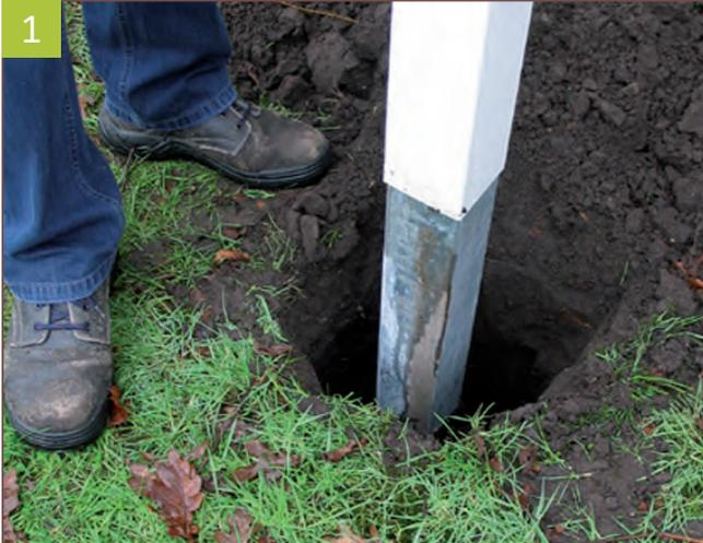
1 | Heben Sie das Erdreich ca. 500-800 mm tief aus. Das Loch sollte etwa 250 x 250 mm breit sein. Setzen Sie nun den Pfosten in das vorbereitete Erdloch.
