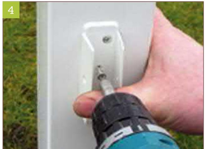
4 | Schrauben Sie nun die Zwischenanschlusshauben entsprechend der Querriegelhöhen an die Pfosten. Verwenden Sie hierzu die im Lieferumfang enthaltenen Schrauben. Nachdem Sie alle Halterungen an den Pfosten angebracht haben, hängen Sie die Zaunelemente ein.
