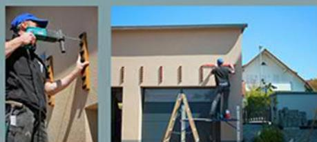
Die Unterkonstruktionsleisten werden vertikal installiert und waagrecht ins Lot gebracht (max. Achsmaß 60 cm).
