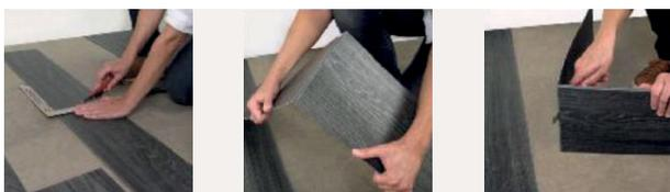
Die Elemente müssen spannungsarm und fugendicht in den Kleber eingelegt und innerhalb der vorgeschriebenen Zeit sorgfältig mit einer Lamellenwalze angedrückt werden. Bis zur vollen Durchhärtung des Klebers ist der Boden vor Temperaturänderungen und Sonneneinstrahlung zu schützen.
