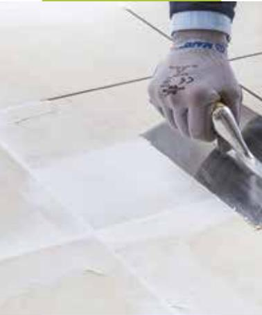
Spachteln und Verschließen von Fugen in einem bestehenden Fliesenbelag mit planeo Safeprep
